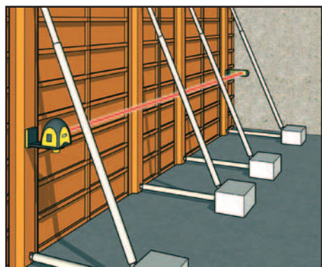
Zaměření roviny betonářského bednění
