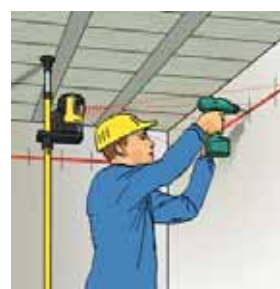
Krížový laser uchytený na rozťahovacej tyči STROP - PODLAHA
