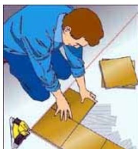
Kladenie dlažby laserovým uholníkom
