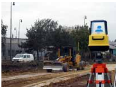
Grejder riadený rotačným laserom na stavbe železnice pri Trnave
