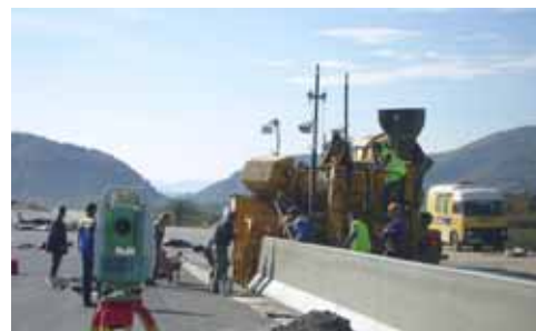
Ukladač betónu Doprastavu riadený totálnymi stanicami na diaľnici pri Žiline
