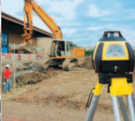
Výšková kontrola výkopov
