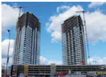
Obr. 1 Budova Panorama City v Bratislave
