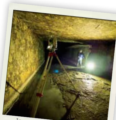
Ing. Garai, Vodo hospodárska výstavba a.s., zameranie priechodnosti odvodňovacieho tunela s Leica TS15, VD Gabčíkovo.
