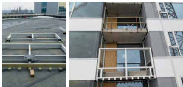
Obr. 3 Kotevné vložky na balkóne JV steny a konštrukcia zábradlia
