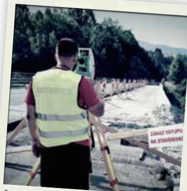
Ing. Peter Harman, GEODETICS s.r.o., predrealizačné zameranie konštrukcie mosta s Leica TCR1201, Dolný Kubín.
