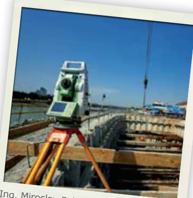
Ing. Miroslav Pokorný, GPS TEAM s.r.o., zakladanie piliera pri výstavbe Starého mosta s Leica TS12, Bratislava.
