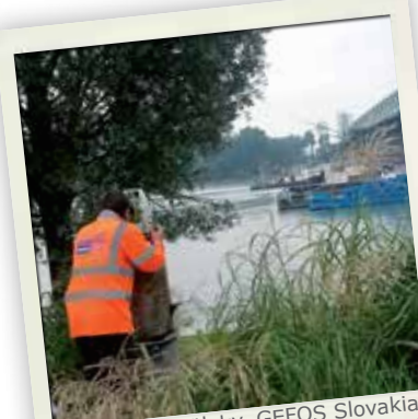
Ing. Tibor Füleky, GEFOS Slovakia s.r.o., kontrola polohy Starého mosta s Leica Viva TS15 pri jeho vysúvaní, Bratislava.
