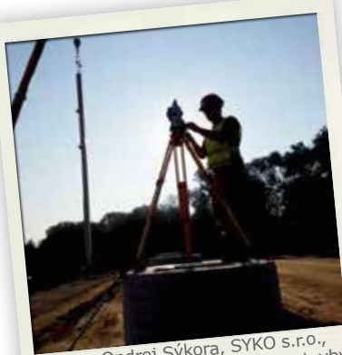
Ing. Ondrej Sýkora, SYKO s.r.o., vytyčovanie osového systému stavby pre osadenie prefabrikovaných konštrukcií s Leica Viva TS15, Žilina.
