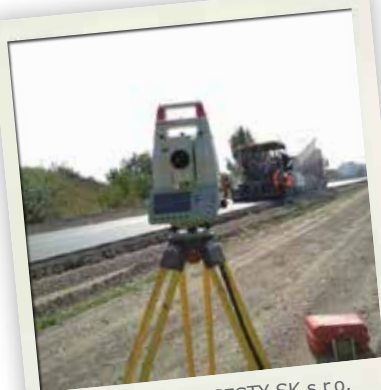
Ing. Harman, CESTY SK s.r.o., navigácia finišera pomocou Leica TS16, okolie Šamorína.
