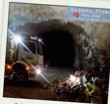
Erika Javorková, Legeo s.r.o., mapovanie s geológom a zameranie navrhnutých kotiev s Leica MS50, obchvat mesta Štokholm.
