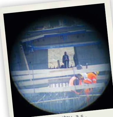
Doprastav, a.s., D1 Fričovce -Svinia- Pohľad cez ďalekohľad TPS1200
