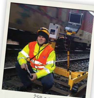
ŽSR a.s., skenovania Strečnianskeho tunela systémom GRP 5000
