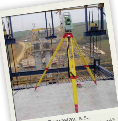
Doprastav, a.s., D1 Fričovce-Svinia-letná betonáž
