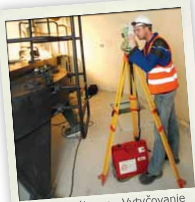
Geoaktúal s.r.o., Vytyčovanie nových kotevných prvkov v šachte reaktora v JE Mochovce
