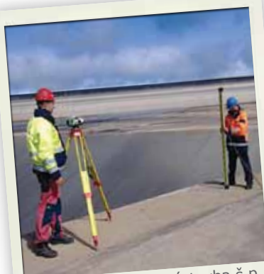
Vodohospodárska výstavba š.p., Meranie vtokového objektu horná nádrž PVE Čierny Váh
