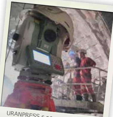
URANPRESS s.r.o., usmerňovanie razienej tunelovej rúry s Leica TS12L, tunel Ovčiarско.
