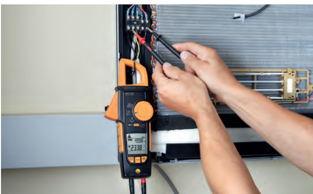
Meranie napätia na klimatizačnej jednotke s testo 770 .
