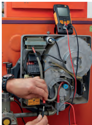
Príprava merania ionizačného prúdu
