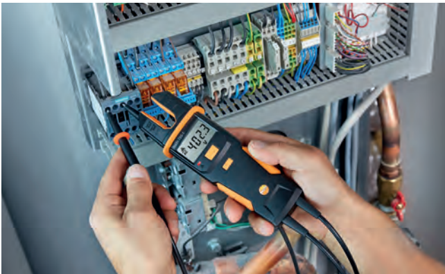
Testovanie napätia na tepelnom čerpadle s testo 755 .
