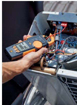
Pripojenie kliešťového multimetra k vonkajšej chladiacej jednotke.
