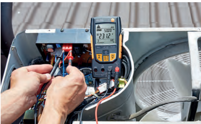
Meranie napätia na vonkajšej chladiacej jednotke s testo 760 .
