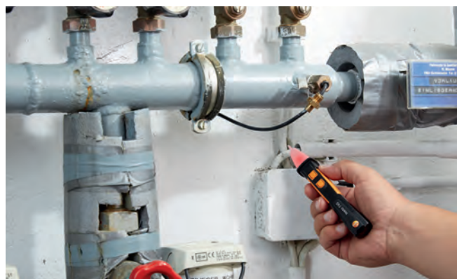
Kontrola napätia na rozvádzači s testo 745 .
