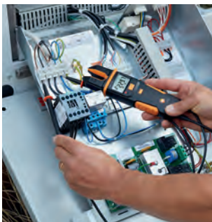
Meranie napätia na kompresore.
